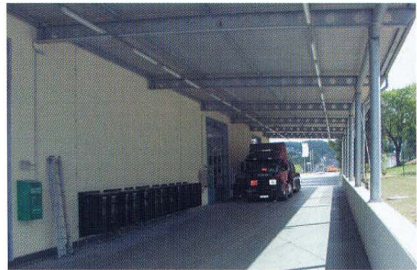
Behandlungsanlage und Abfüllplätze der neuen ZEA
